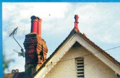
Dezent an der Nordseite montiert: Die Schüssel schießt über den First
